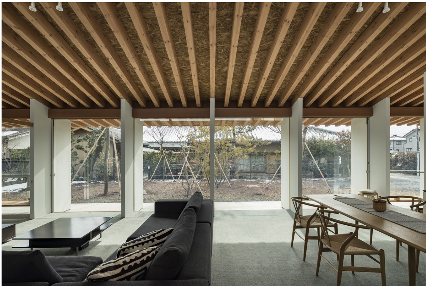
長い庭の面には薄い壁柱を一定間隔で連ね、間は全て開口にした。
